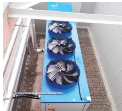
Nový zdroj vykurovania budovy - tepelné čerpadlá
