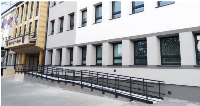
Rampa zabezpečujúca bezbariérovosť vstupu do budovy MsÚ
